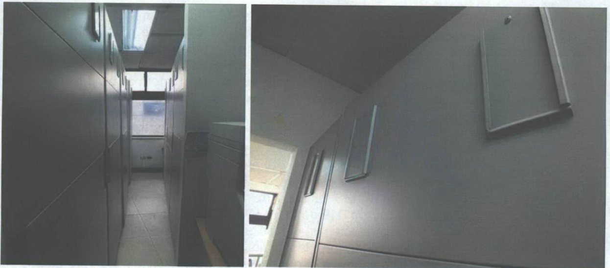
Fotografía No. 5 Ausencia de señalización en las áreas de archivo
