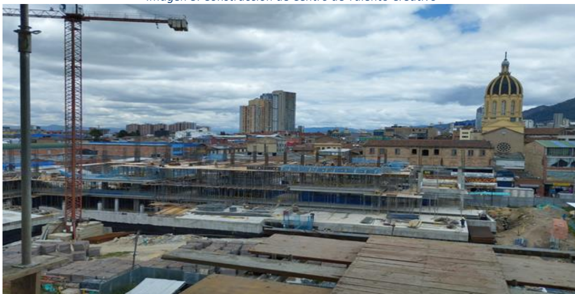
Imagen 3. Construcción de Centro de Talento Creativo
