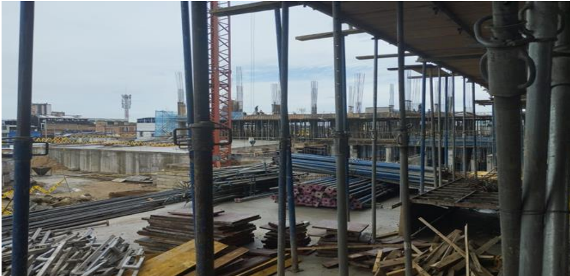
Imagen 4. Construcción del Centro de Talento Creativo
