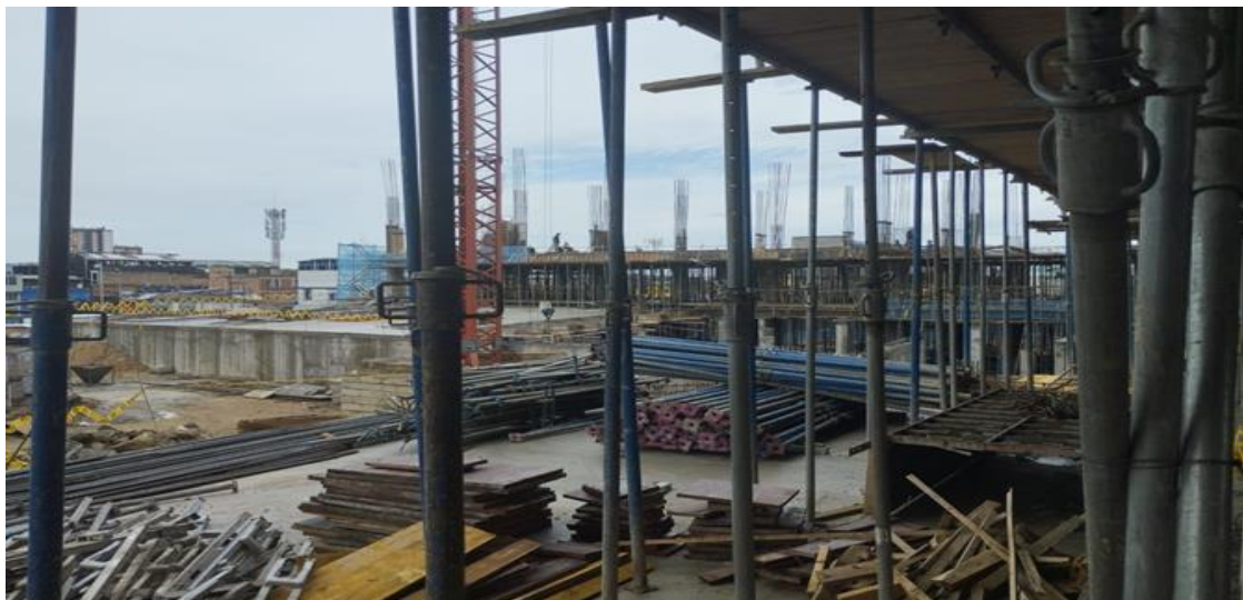
Imagen 4. Construcción del Centro de Talento Creativo
